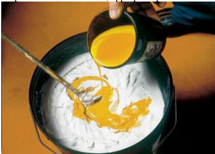
Étape 2 - Colorer avec nos peintures, mélanger avec le batteur; laisser reposer pendant 24 heures.
