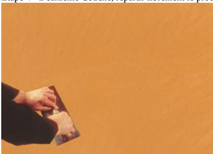
Étape 5 - Lorsque le produit commence à sécher procéder à la compression et aux phases de polissage.
