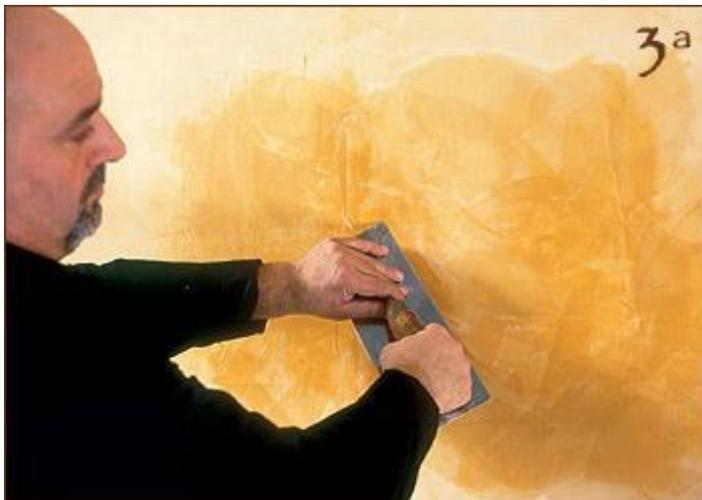
Étape 8 - ... 30 secondes après, avec la lame à enduire propre, polir de la façon indiquée. Quand on passe au m<sup>2</sup> suivant, se superposer à la zone précédente pour éliminer tout signe de jonction.
