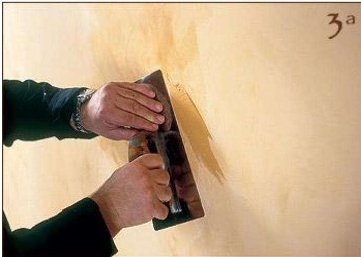
Étape 7 - À ce point, le produit pénètre dans chaque petite fissure et, avec une légère pression, la surface devient parfaitement lisse. Appliquer... et enlever Spatula Stuhhi sur environ 1 m<sup>2</sup> et ...
